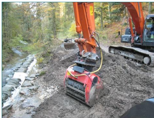
Schéma 6 : le godet-concasseur fixé sur un bras de pelle, qui terrasse et broie la terre.
